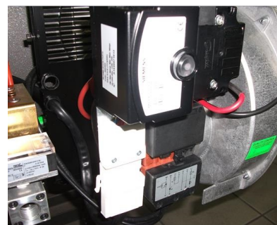
9 - Осуществить электрические подключения в соответствии с прилагаемой электрической схемой;
