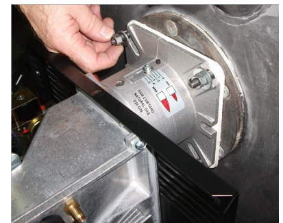
6 - Зафиксировать горелки на котел;
