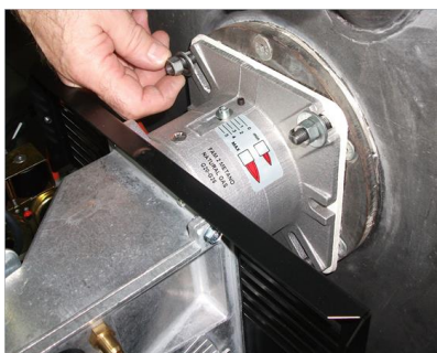
7 - Зафиксировать горелки на котел;
