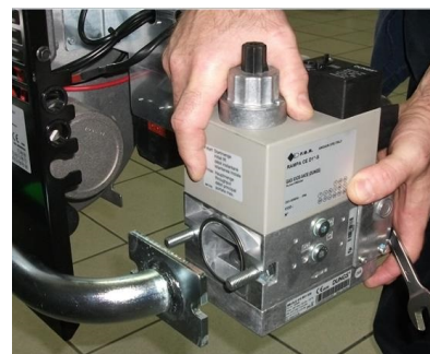
9 - установить электроклапан на Труба ГАЗОВОЙ рампы;
