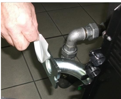
7 - Снять заглушку из Труба ГАЗОВОЙ рампы;
