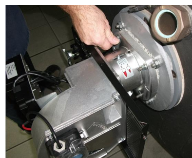
6 - Зафиксировать горелки на котел;
