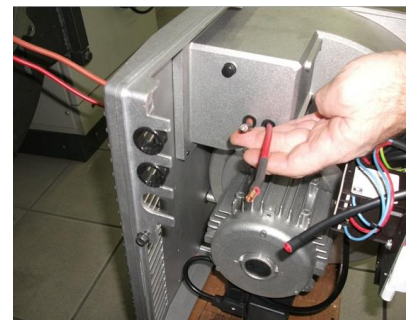
12 - пропустив кабель электрода поджига и кабель электрода ионизации через отверстие;
