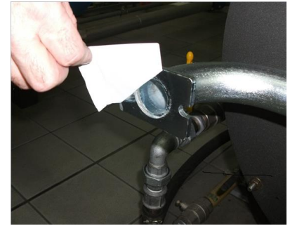
6 - Снять заглушку из Труба ГАЗОВОЙ рампы;
